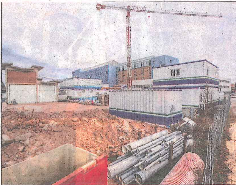
Detalle de las obras que se están ejecutando en el Hospital Santa Bárbara de Soria. MARIO TEJEDOR
